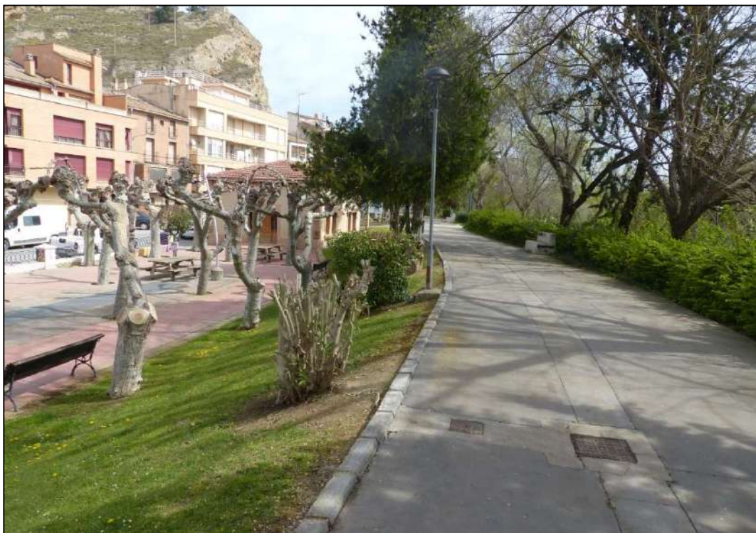
Figura 38. Tramo de la carretera NA-8701 a su paso por el casco urbano de la localidad, tras atravesar el puente sobre el río Arga. Fotografías de las arquetas por las que se inicia la inundación de este tramo de carretera. La última fotografía muestra la vista desde la mota de protección del municipio en este punto.
