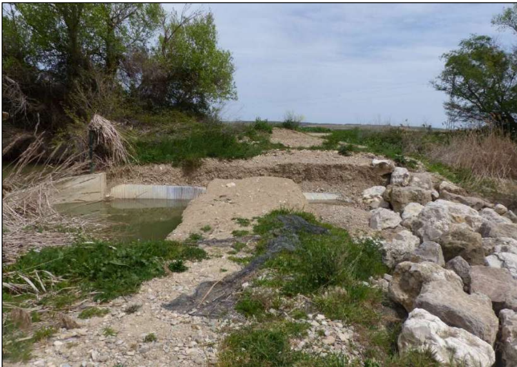
*Fotografía superior: Vista del punto por el que el cauce del meandro abandonado - entre falces y Peralta - retorna al cauce del Arga. *Fotografía inferior: Vista del punto aguas arriba del meandro abandonado en la zona entre Falces y Peralta.
