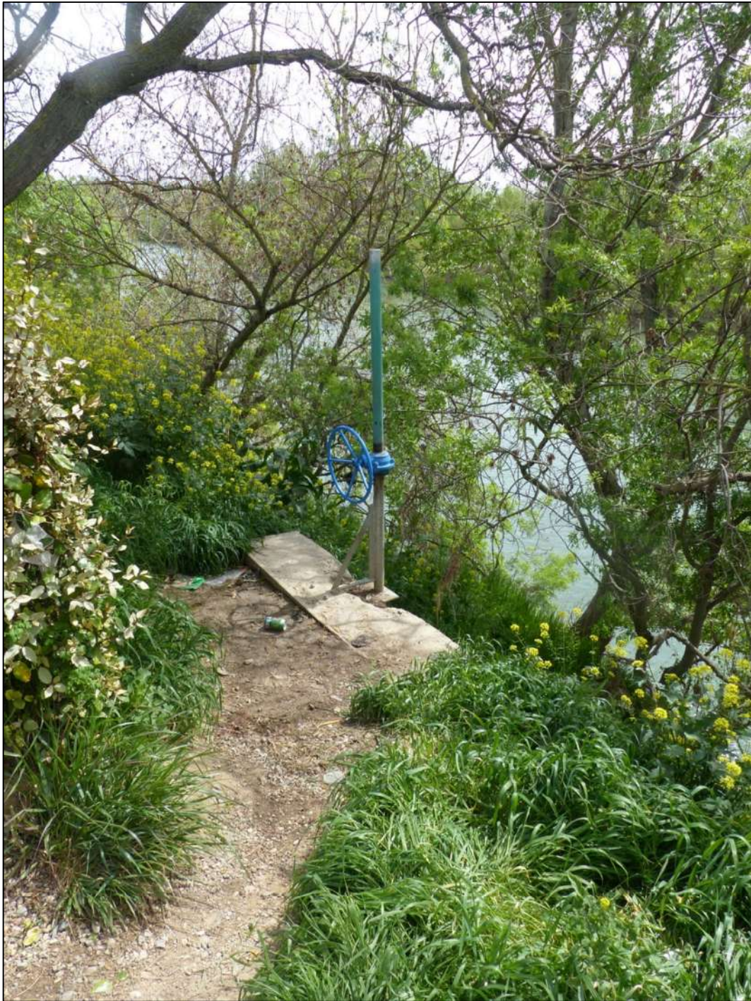
Figura 42. Fotografías tomadas en la zona del meandro abandonado del Arga en el tramo paralelo a la calle Valle de Ultzama de la localidad. En esta zona se encuentra otra de las tajaderas principales para la protección del casco urbano [fotografía de esta página].
