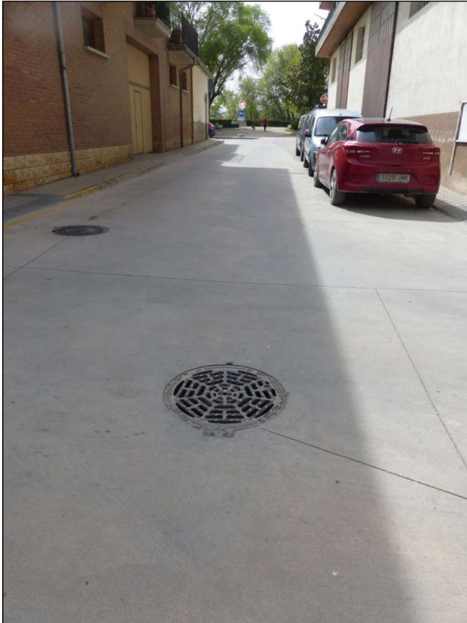
*Fotografía: Detalle de arquetas en calle Aguardienterías.
