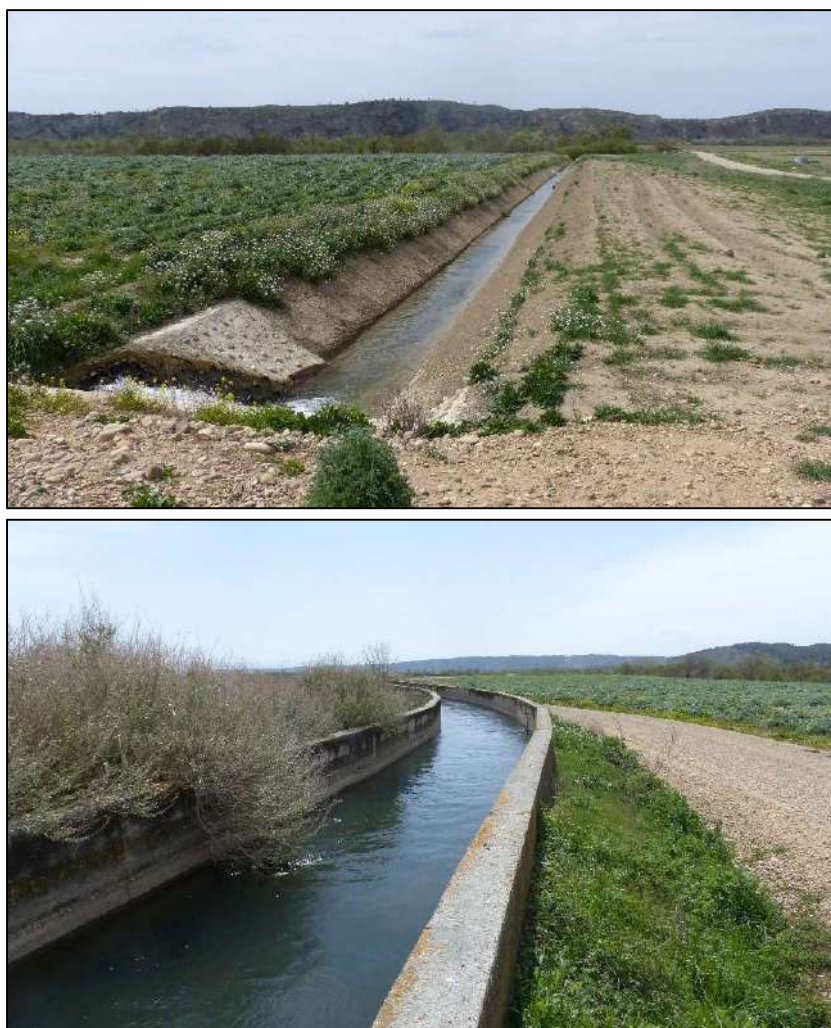
Figura 29 Imagen del río Arlas y sus derivaciones, canalizadas en el término municipal de Peralta.
