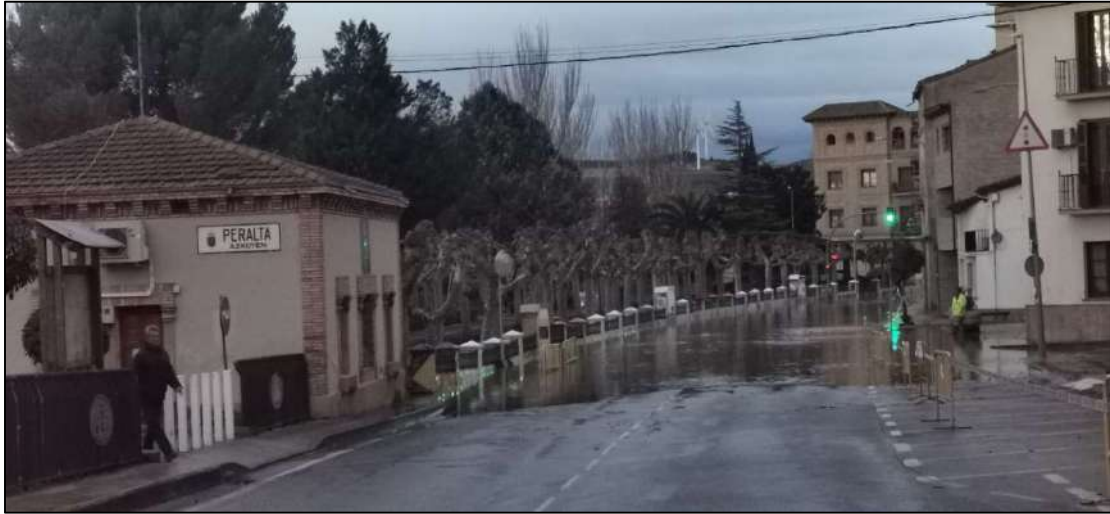
*Vista de la carretera NA-8701 cortada por las inundaciones.
