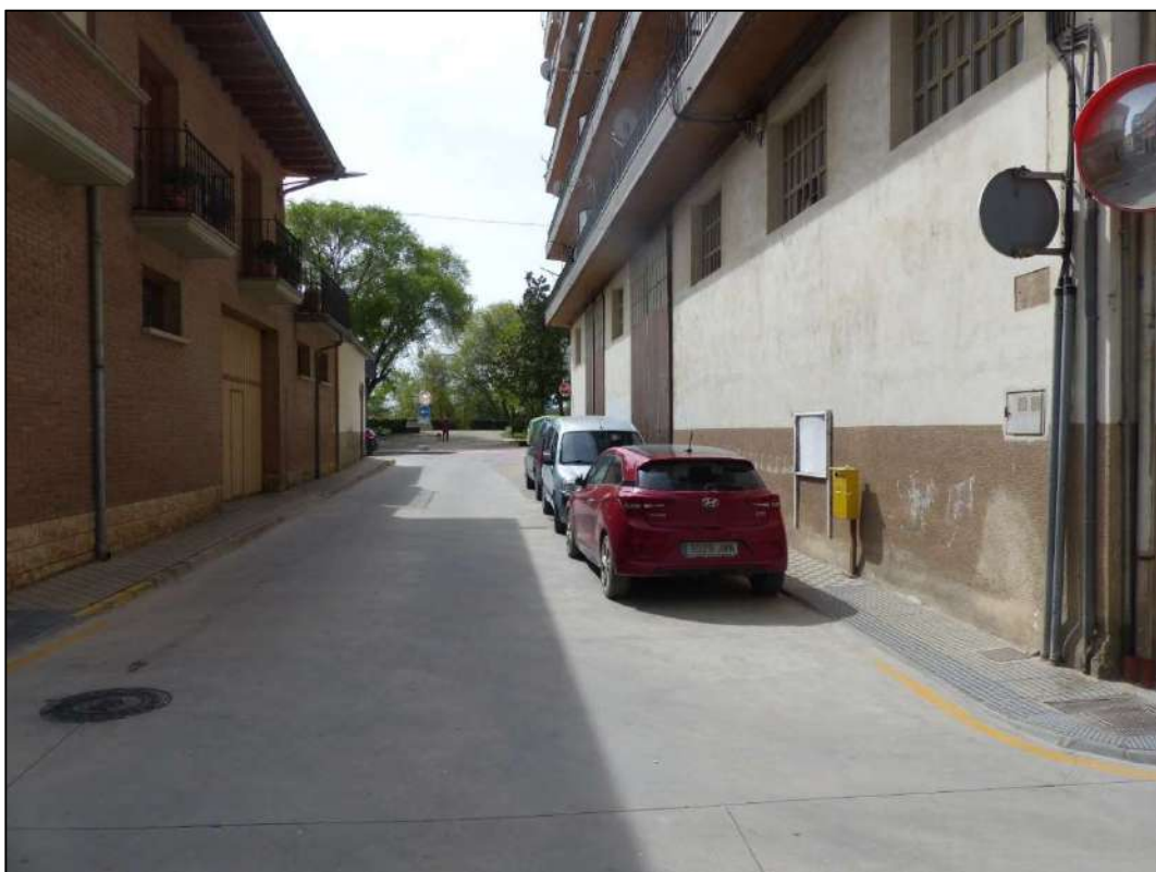
*Fotografía superior: Arquetas en calles Rio y Aguardienterías. *Fotografía inferior: Calle Aguardienterías.
