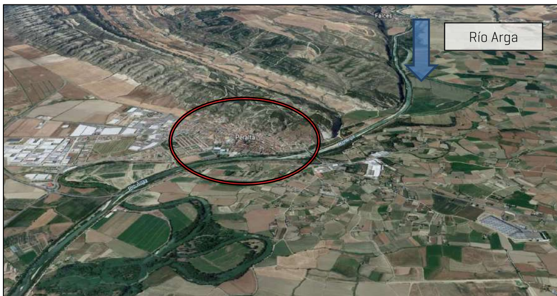
Figura 1 Vista aérea, desde aguas abajo de Peralta-Azkoien, de la cuenca del río Arga a su paso por la localidad. Imagen obtenida de GoogleEarth.
