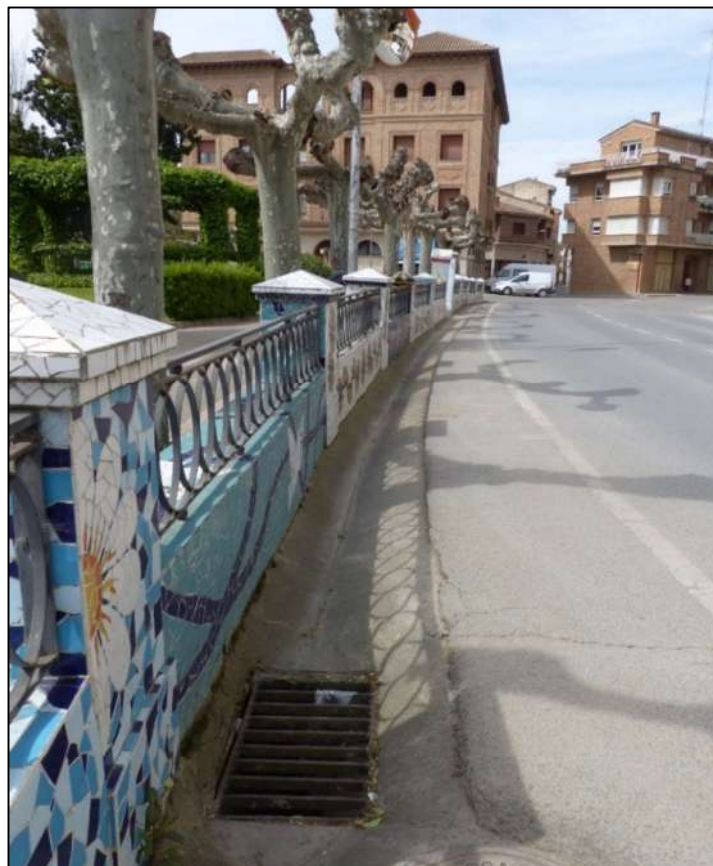
Figura 39. Zona que resultó afectada en la reciente inundación de diciembre de 2021. En concreto se trata de la zona de confluencia de las calles Río, Irurzun y Méndez Núñez. Próxima a esta zona, en la carretera NA-8701 se encuentra una segunda arqueta que provoca la inundación hacia esta zona.
