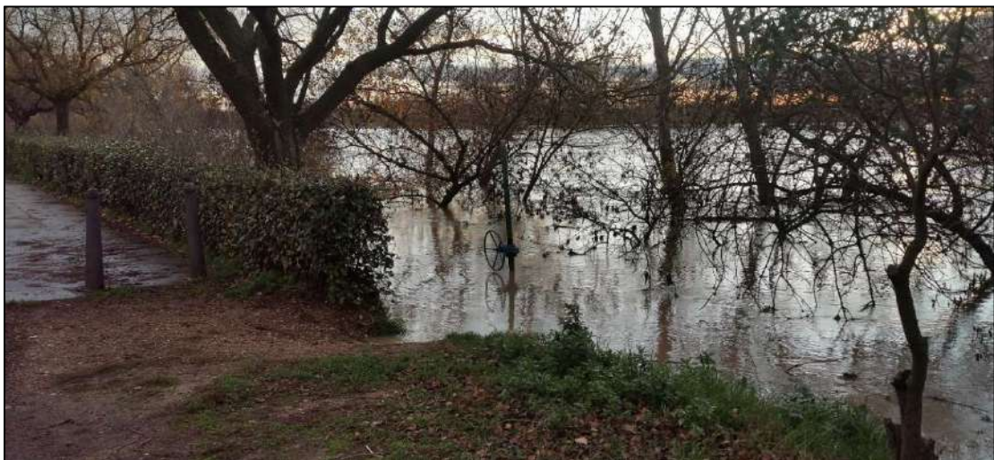
*Compuerta de la mota prácticamente inundada por la crecida del río.
