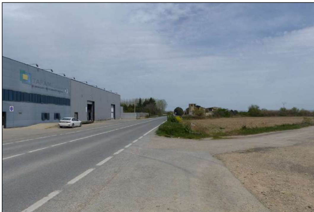
Figura 43. Imágenes de las carreteras de la localidad más comúnmente afectadas por los desbordamientos del Arga. En la fotografía superior se muestra un tramo afectado en la carretera NA-128. En la fotografía inferior se muestra un tramo afectado en la carretera NA-115 que comunica con Tafalla.
