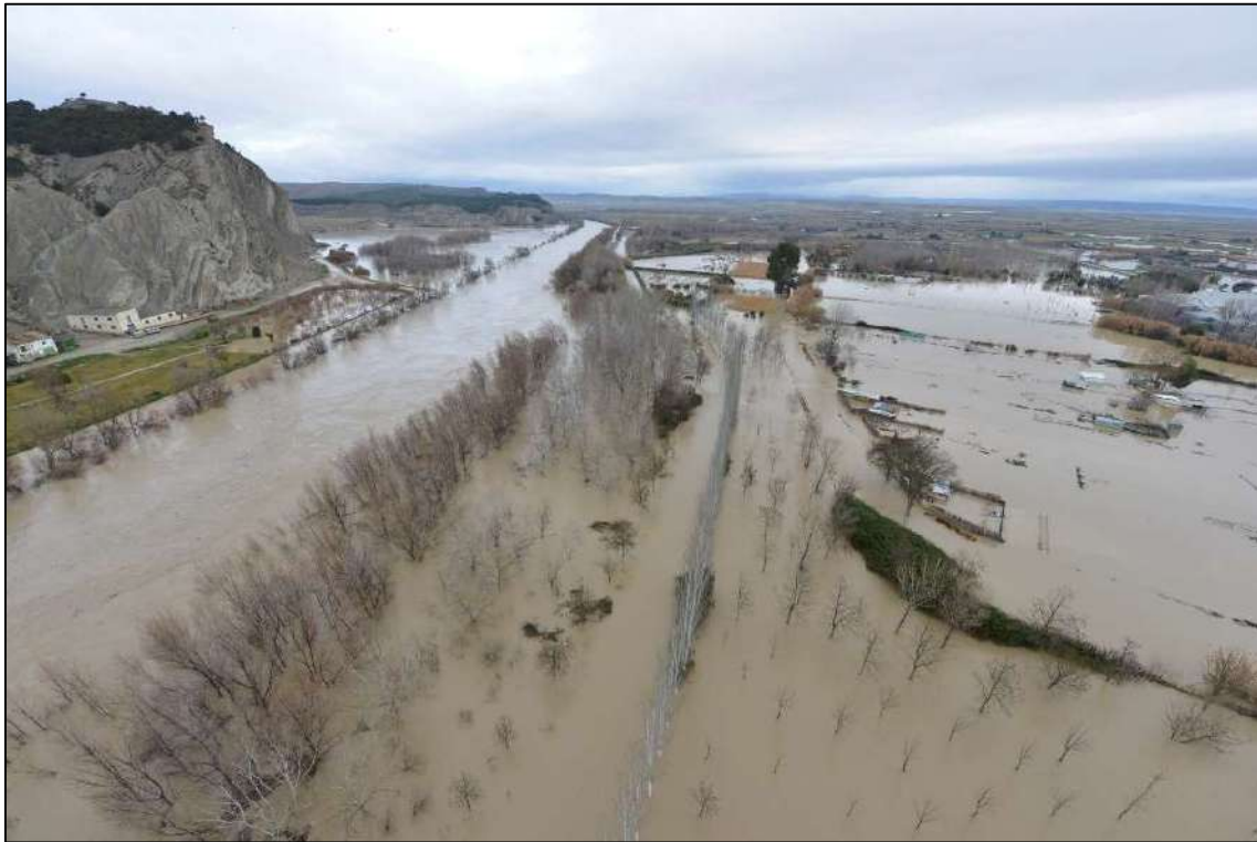
Figura 23 Imagen los desbordamientos en ambos márgenes, en el tramo del Arga entre Falces y Peralta. Vista hacia aguas arriba, desde el casco urbano de Peralta.
