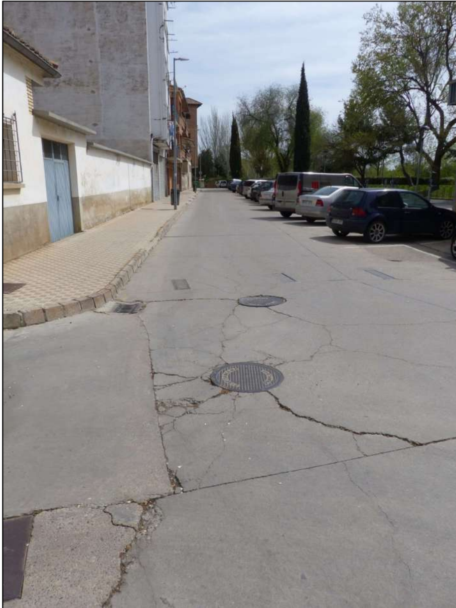
*Fotografía: Detalle de arquetas en calle Río.
