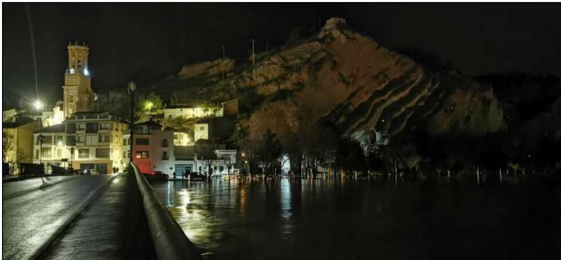
*Afecciones al casco urbano, en la margen derecha del río, aguas arriba del puente de la localidad.
