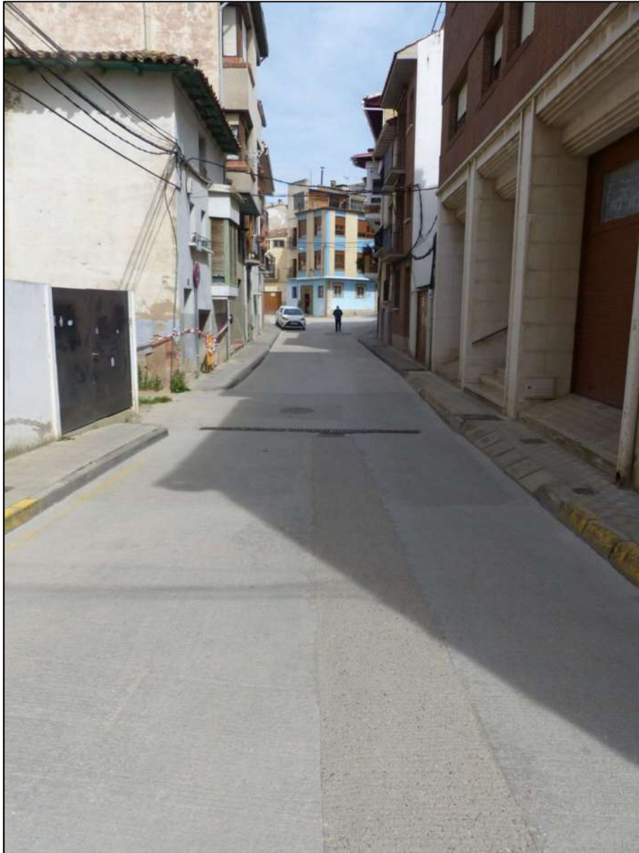
*Fotografía: Detalle de arquetas – punto bajo - en calle Aguardienterías.
