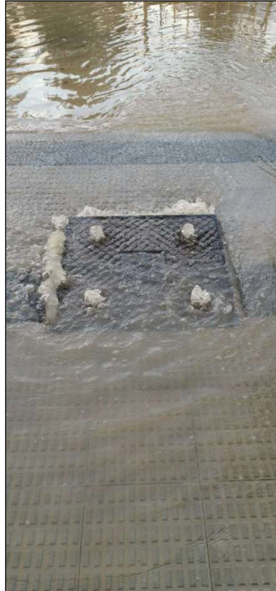
*Izquierda: calle Aguardienterías anegada. *Derecha: retorno de agua del Arga por la red de pluviales de la localidad.
